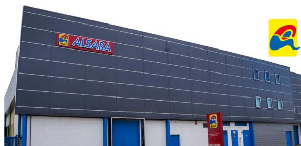
Figura 20. Instalaciones grupo Alsara Fuente: Alsara
