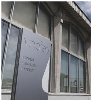
Figura 29. Instalaciones Vinolea Fuente: Vinolea
