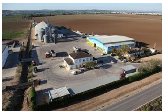
Figura 26. Instalaciones Coare Fuente: Coare
